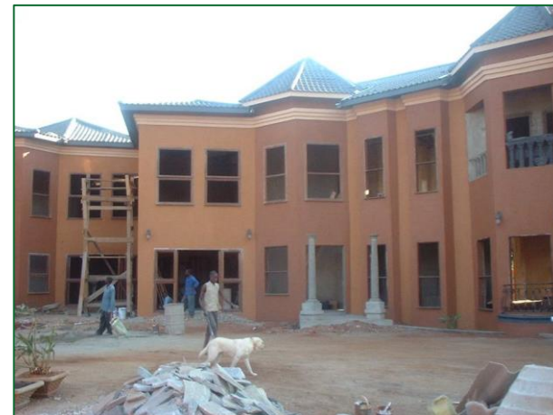
Neubau eines Mehrfamilienhauses in Kabulonga/ Lusaka 2006
