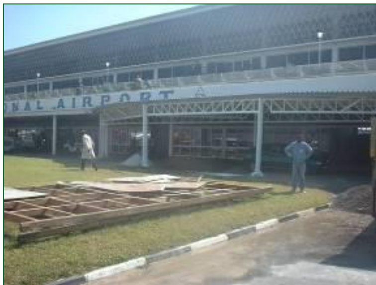
Abbildung 22 Sanierungsarbeiten am LIA
