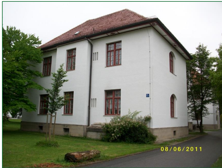
Abbildung 19 Gebäudeansicht München Haar
