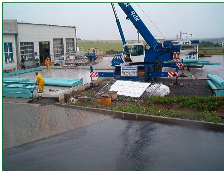
Abbildung 11 Bauarbeiten am Autohaus
