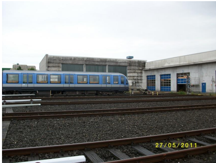
Abbildung 15 SWM Betriebshof U-Bahn
