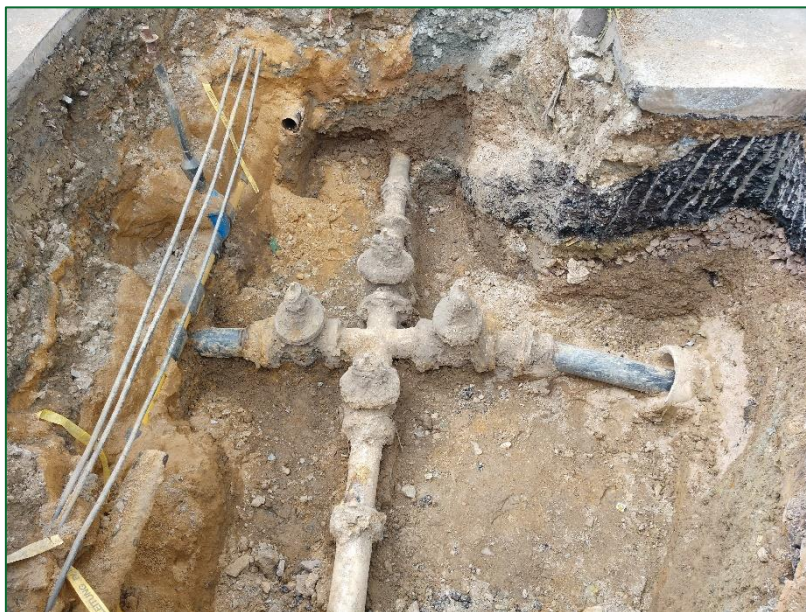
Abbildung 12 Leitungskreuzung Trinkwasser
